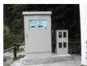
写真⑤-9 発電量表示板
