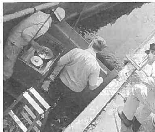
同社前の用水路に小水力発電装置を設置している様子
