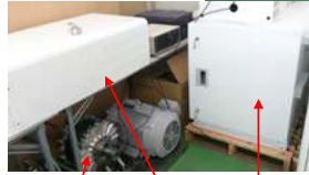
OR発電機+電力変換機+蓄電池
