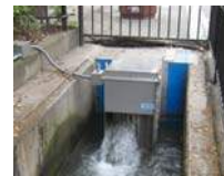
水路設置状況
