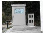
発電量表示板
